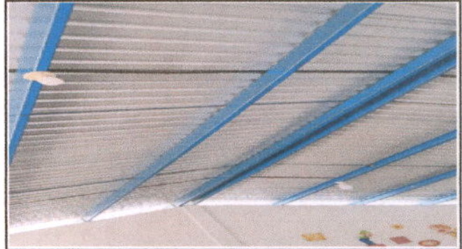
Foto 2: MÓDULO 1 AULAS ESTRUCTURA DE TECHO: Sustitución de estructura de soporte de metal, por metal, REPARACIÓN DE SISTEMA ELÉCTRICO: Sustitución de lamparas tipo LED,
