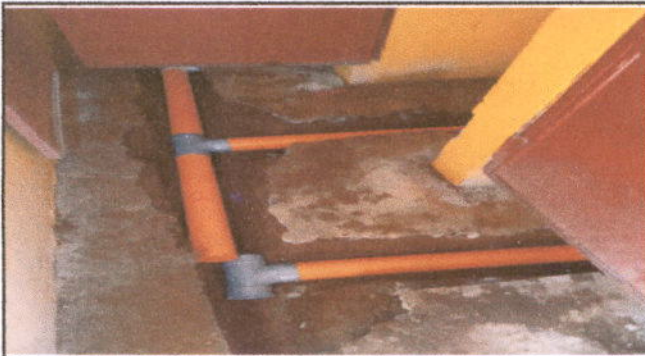
Foto 3: MÓDULO 2 SERVICIOS SANITARIOS: Sustitución inodoro
